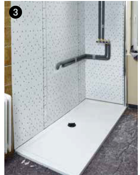
3 Neue Duschwanne setzen
