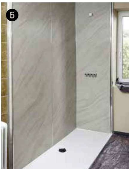
5 Wandverkleidungsplatten anbringen
