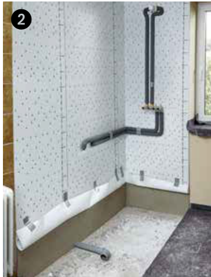
2 Ausbessern, Abdichten & Aufputz installieren
