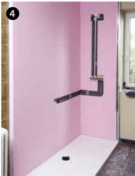
4 Wandmodule anpassen und platzieren
